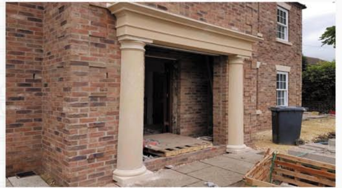
Villa Giriş Kapısı Alemdağ / İSTANBUL
