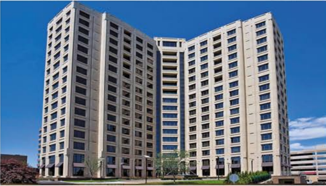
Vien Grup TÜRKMENİSTAN
